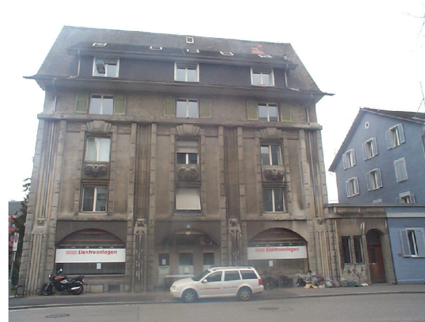
Strassenfassade vor Umbau/ Dachausbau
