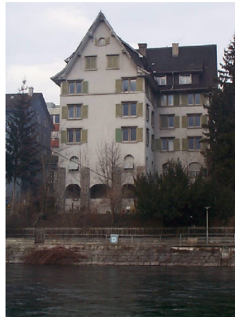
Strassenfassade vor Umbau/ Dachausbau
