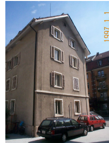
Süd-/ Westfassade vor Sanierung
