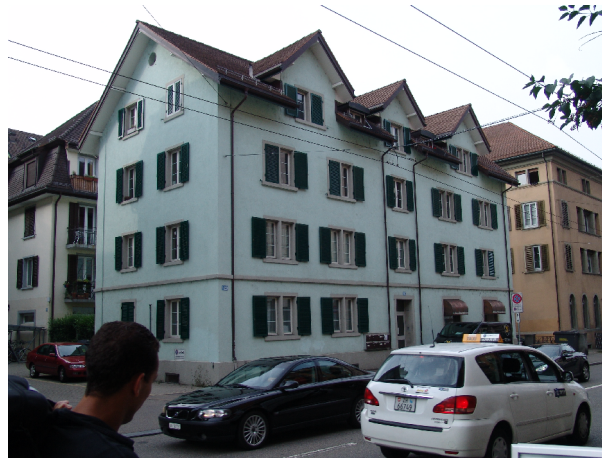
Strassenfassade nach Sanierung
