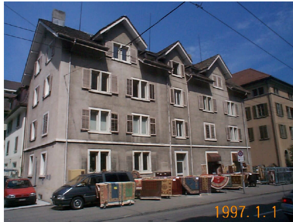
Strassenfassade vor Sanierung
