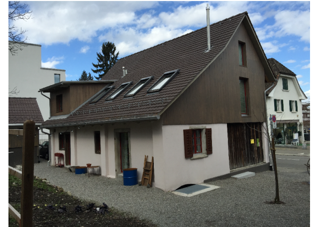
Strassenfassade nach Umbau
