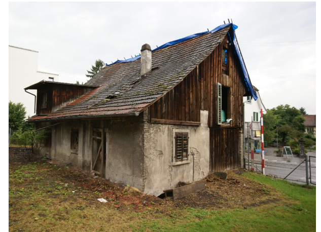
Strassenfassade vor Umbau
