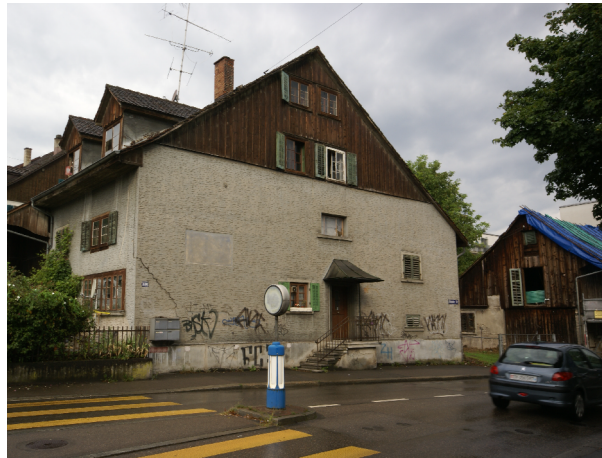
Strassenfassade vor Umbau
