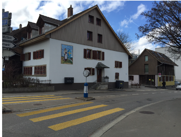
Strassenfassade nach Umbau
