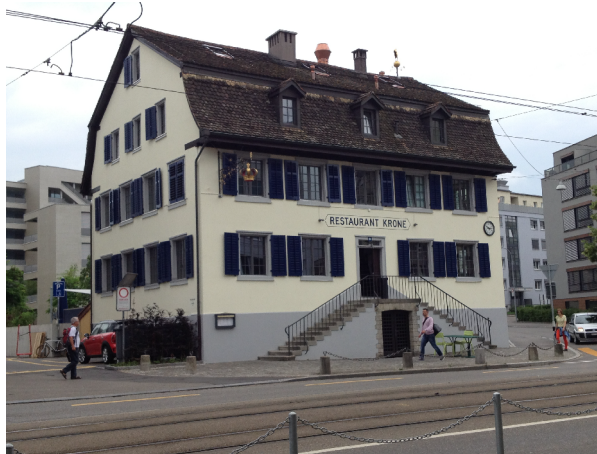
Strassenfassade nach Umbau
