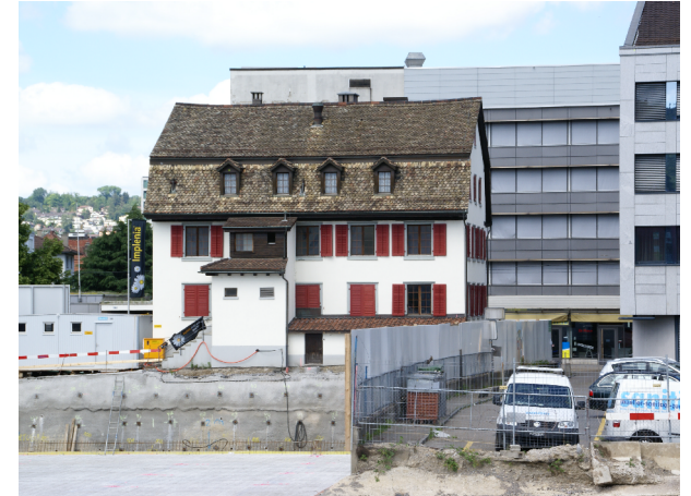
Strassenfassade vor Umbau
