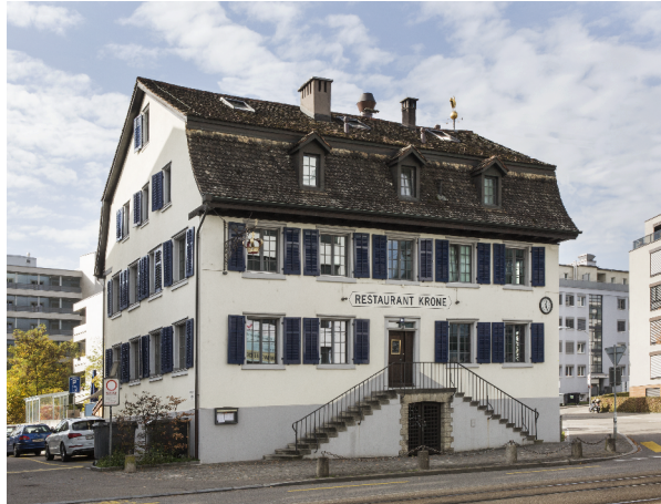
Strassenfassade vor Umbau
