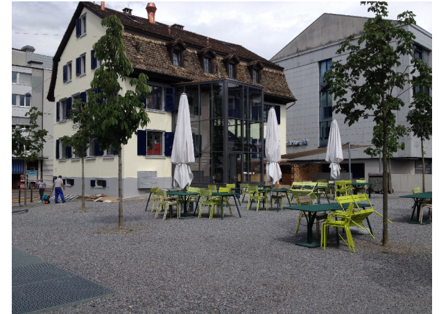
Strassenfassade nach Umbau
