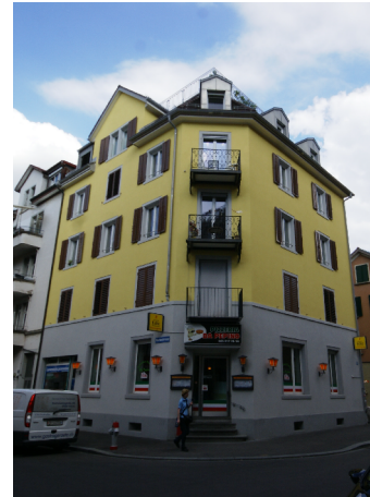
Strassenfassade nach Sanierung/ Aufstockung
