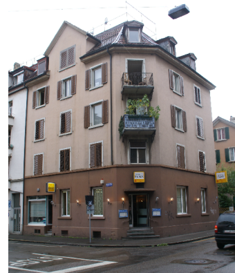
Strassenfassade vor Sanierung/ Aufstockung
