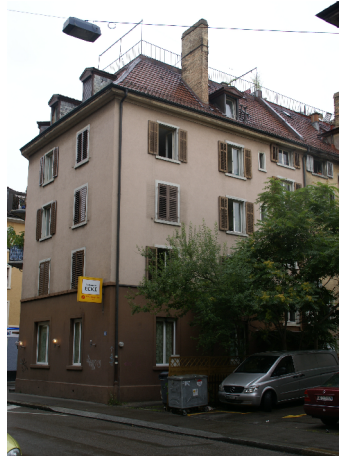
Strassenfassade vor Sanierung/ Aufstockung
