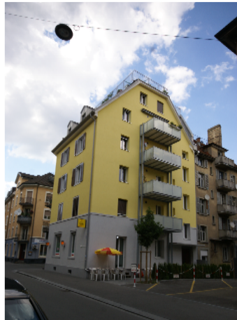
Strassenfassade nach Sanierung/ Aufstockung
