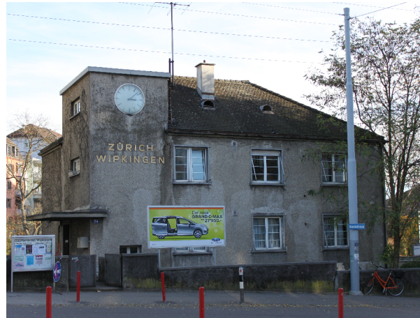
Strassenfassade vor Umbau/ Aufstockung
