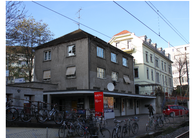
Bahnhoffassade vor Umbau/ Aufstockung
