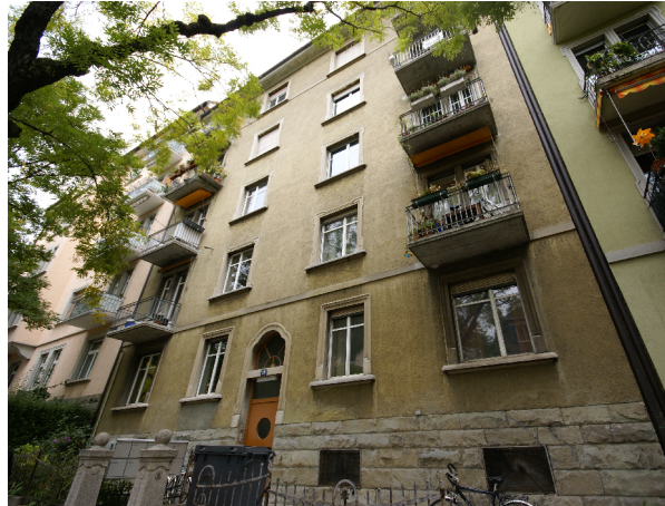
Strassenfassade vor Sanierung/ Aufstockung
