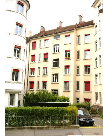
Hoffassade vor Sanierung/ Aufstockung
