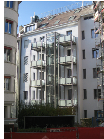
Hoffassade nach Sanierung/ Aufstockung
