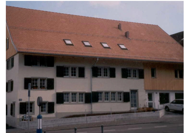
Strassenfassade nach Um-/ Anbau
