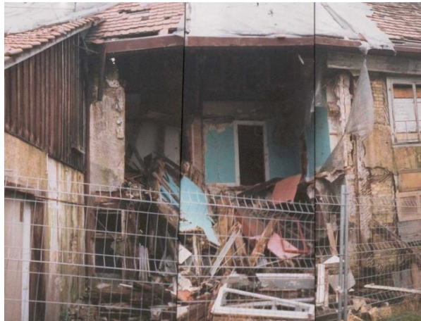
Strassenfassade vor Um-/ Anbau
