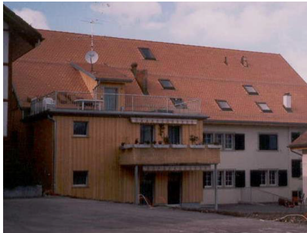
Strassenfassade nach Um-/ Anbau
