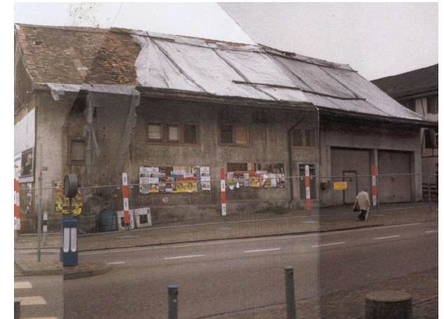
Strassenfassade vor Um-/ Anbau
