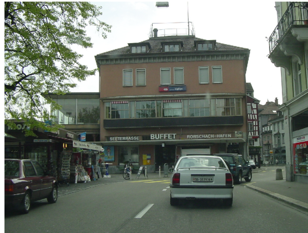
Strassenfassade vor Umbau
