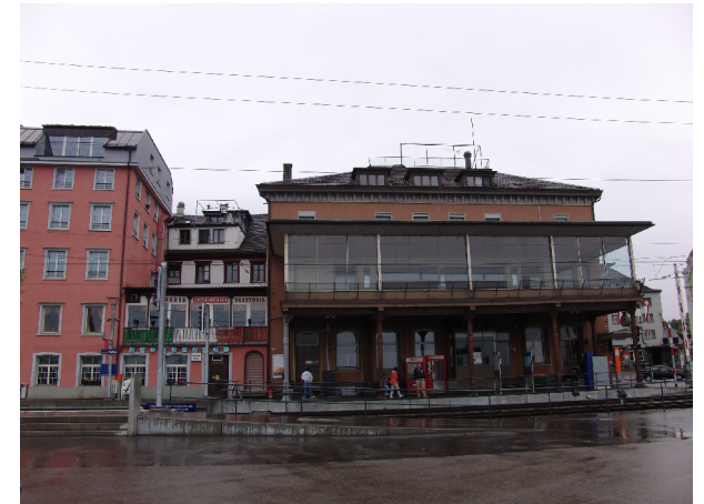
Bahnhoffassade vor Umbau
