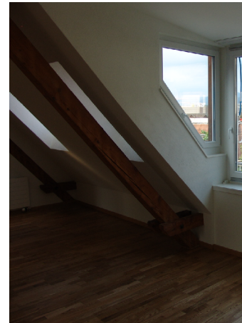
nach Sanierung/ Dachausbau
