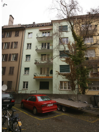
Strassenfassade vor Sanierung/ Dachausbau
