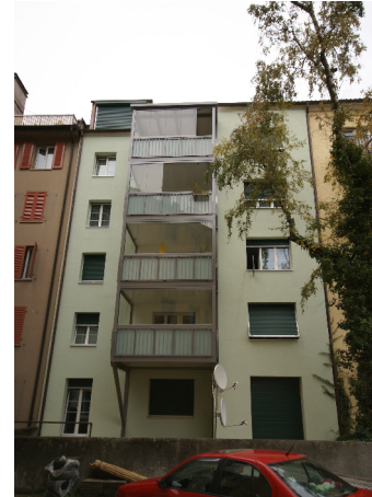
Strassenfassade nach Sanierung/ Dachausbau
