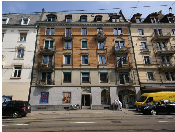
Strassenfassade nach Umbau/ Dachausbau
