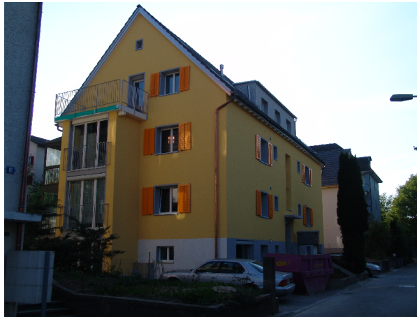
Strassenfassade nach Sanierung
