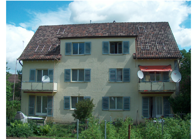
Rückfassade vor Sanierung
