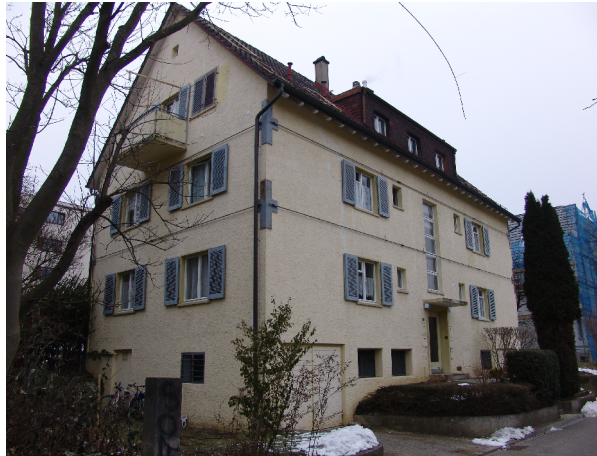
Strassenfassade vor Sanierung
