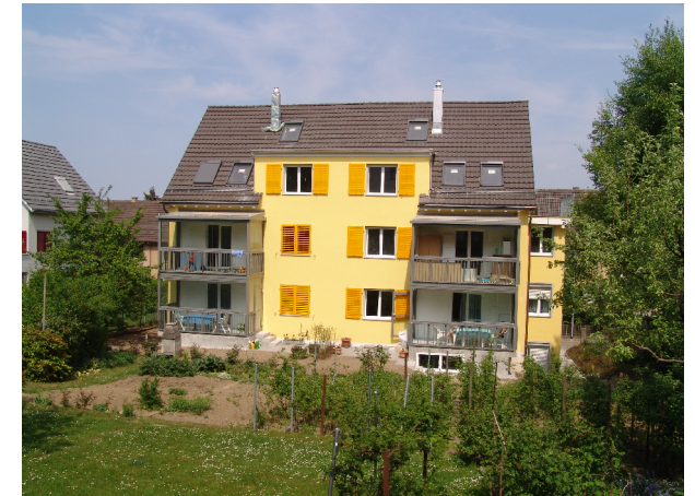
Rückfassade nach Sanierung
