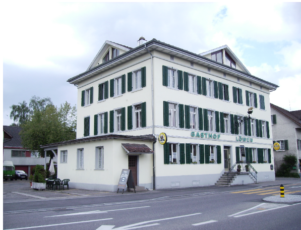
Strassenfassade nach Umbau/ Dachausbau
