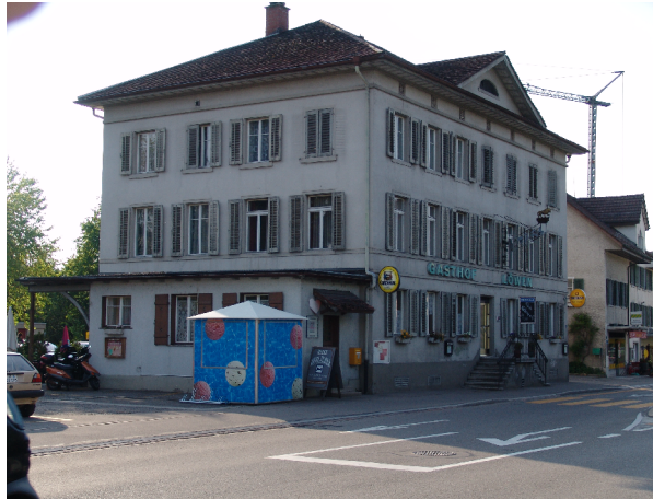
Strassenfassade vor Umbau/ Dachausbau
