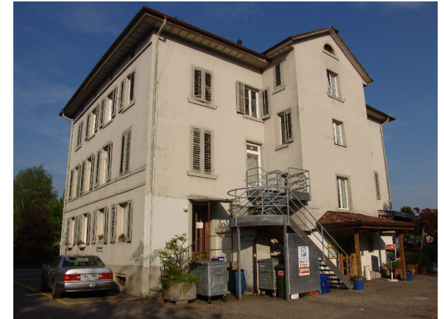
Strassenfassade vor Umbau/ Dachausbau
