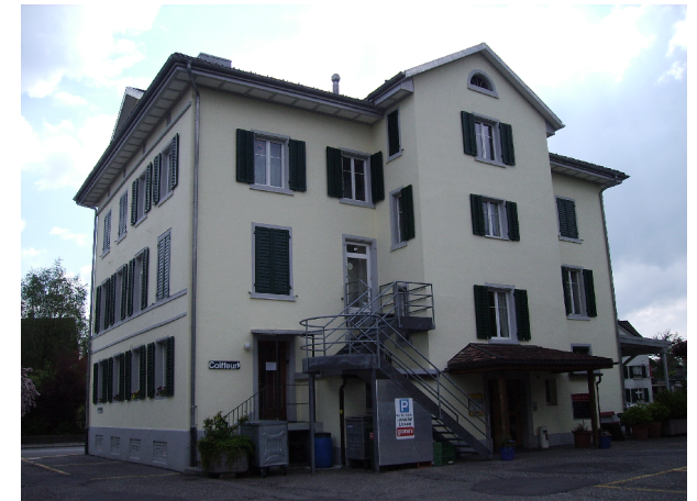
Strassenfassade nach Umbau/ Dachausbau
