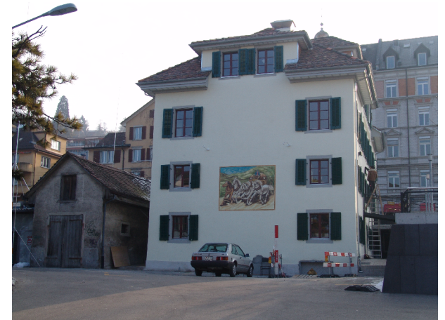
Strassenfassade nach Sanierung
