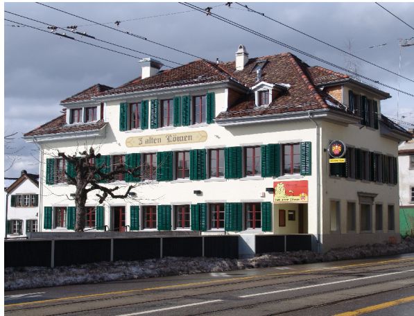
Strassenfassade nach Sanierung
