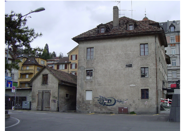
Strassenfassade vor Sanierung
