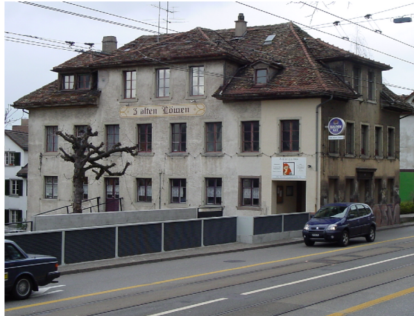
Strassenfassade vor Sanierung
