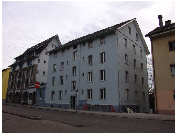
Strassenfassade nach Sanierung/ Dachausbau
