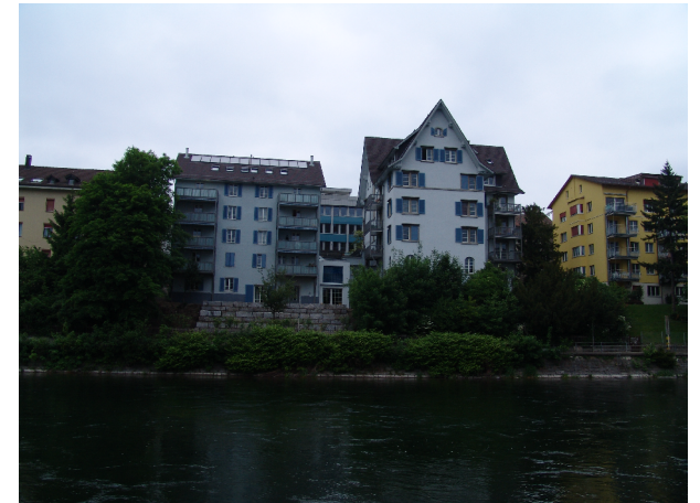
Strassenfassade nach Sanierung/ Dachausbau
