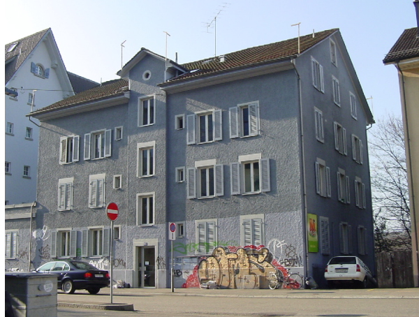
Strassenfassade vor Sanierung/ Dachausbau
