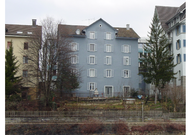
Strassenfassade vor Sanierung/ Dachausbau
