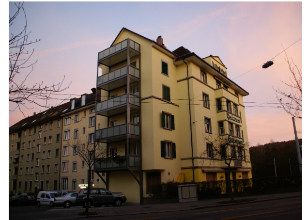
Strassenfassade nach Sanierung/ Dachausbau
