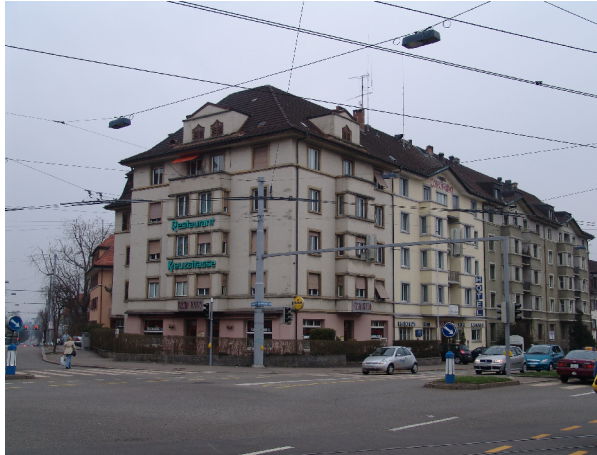
Strassenfassade vor Sanierung/ Dachausbau
