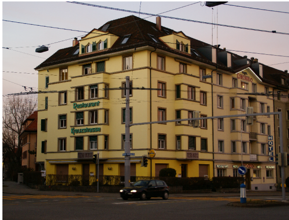
Strassenfassade nach Sanierung/ Dachausbau
