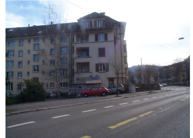
Strassenfassade vor Sanierung/ Dachausbau
