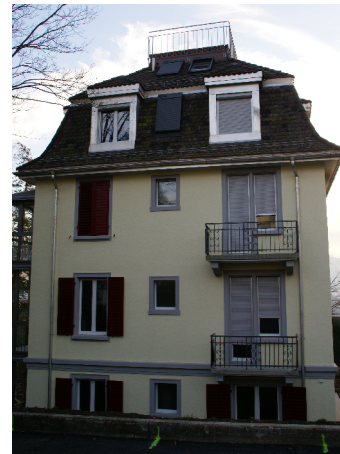
Strassenfassade nach Umbau/ Aufstockung
