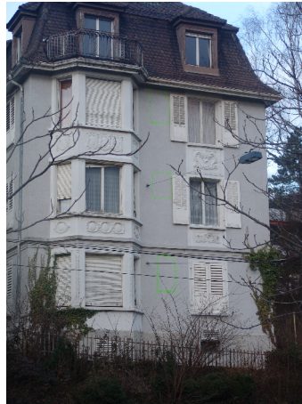
Strassenfassade vor Umbau/ Aufstockung
