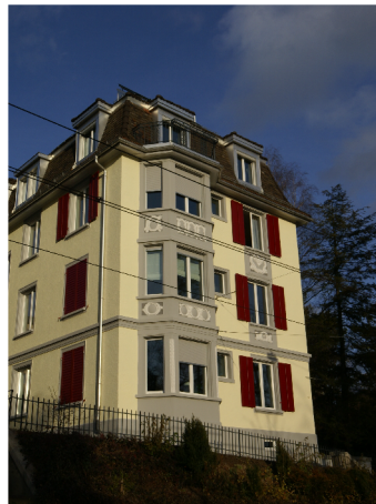
Strassenfassade nach Umbau/ Aufstockung
