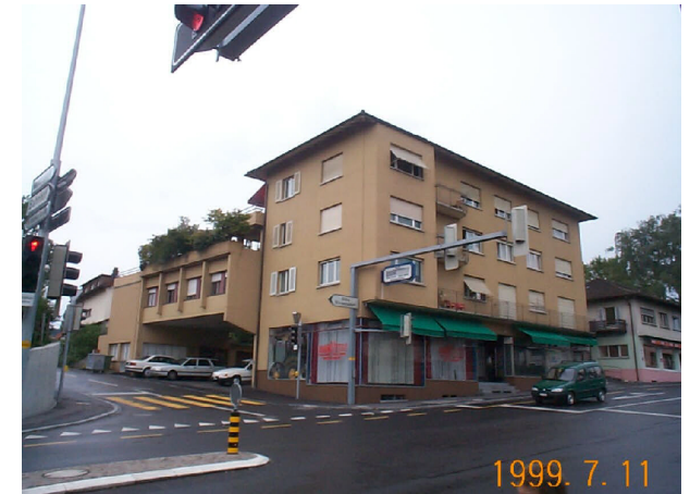
Strassenfassade vor Umbau/ Aufstockung
