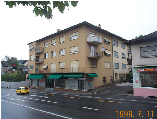
Strassenfassade vor Umbau/ Aufstockung
