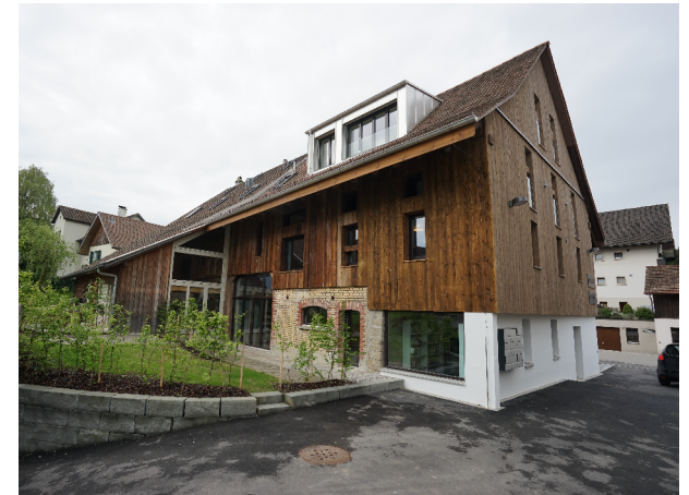
Strassenfassade nach Umbau/ Neubau
