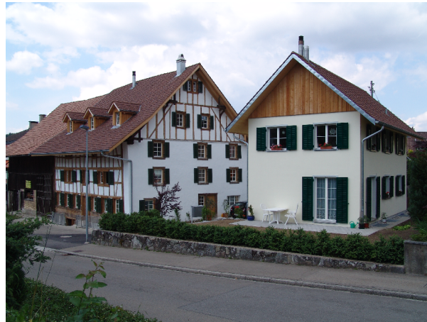
Strassenfassade nach Umbau/ Neubau
